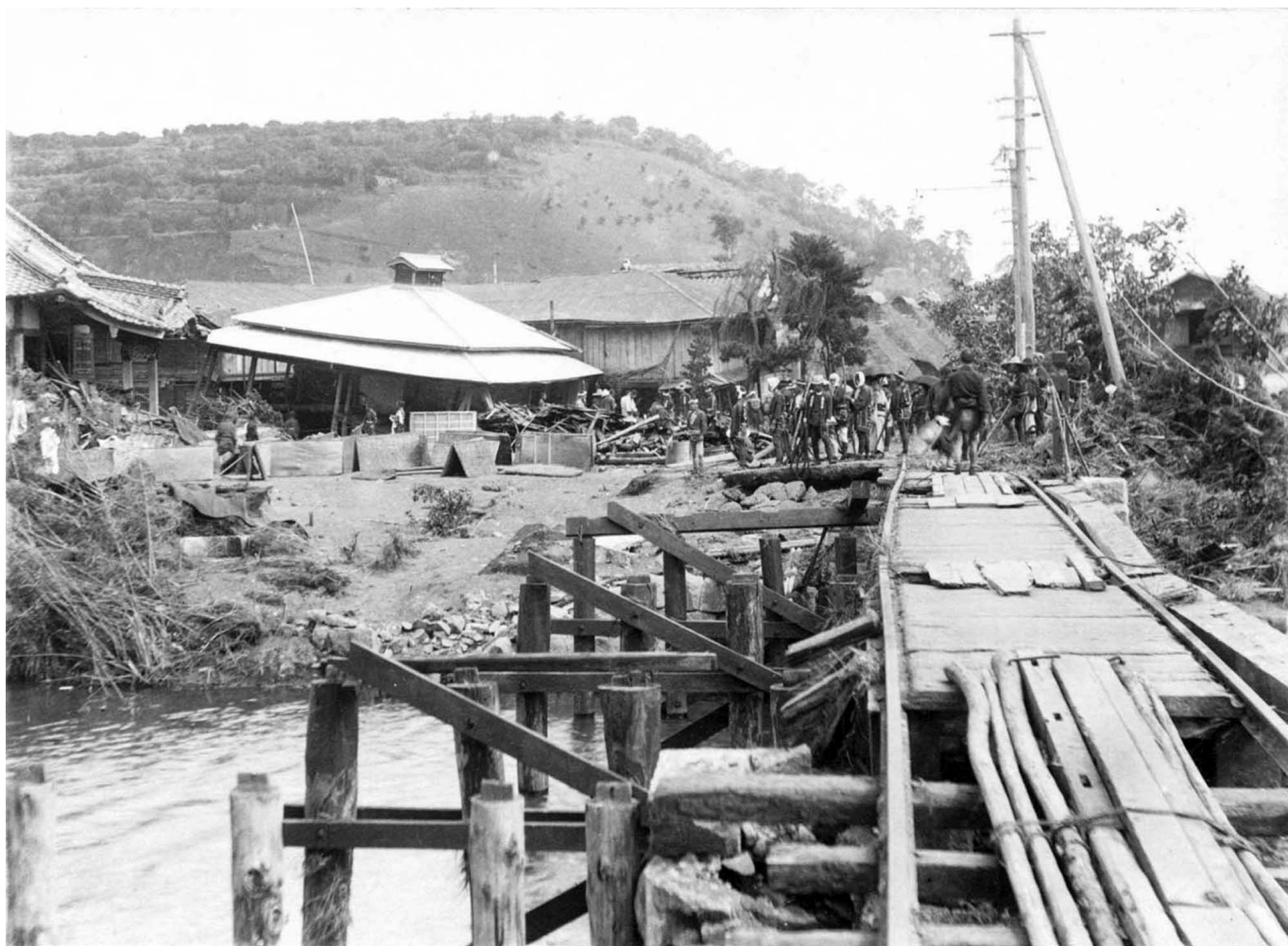
図1 1902年9月28日被災後の国道1号線親木橋付近の様子 線路は小田原電気鉄道
